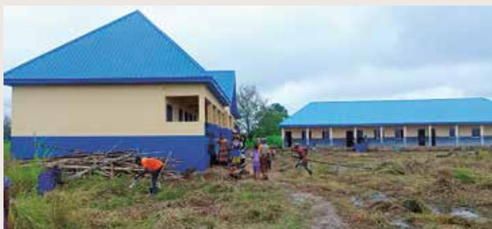
Die beiden neuen Schulgebäude in Ezzagu, Nigeria
